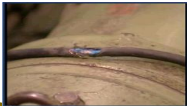
裸露电线与导体接触
